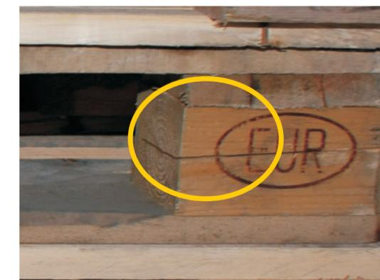
Atļauts izmantot paletes, kurām ir ieplaisājuši bloki, taču ar nosacījumu, ka nav redzamas na las.
